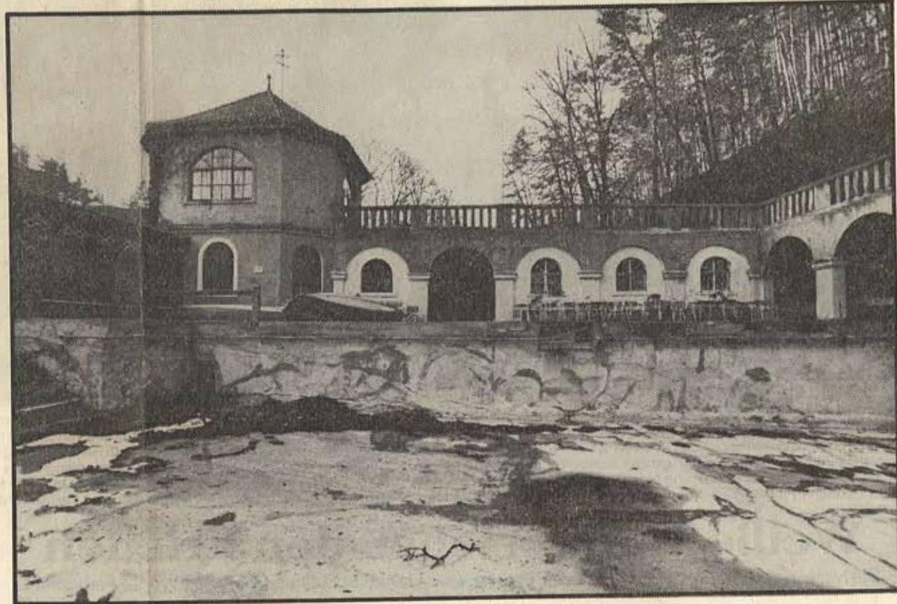
Bild mit Trauerrand: Seit der Schließung 1988 verfällt das Pottensteiner Felsenschwimmbad immer mehr.
